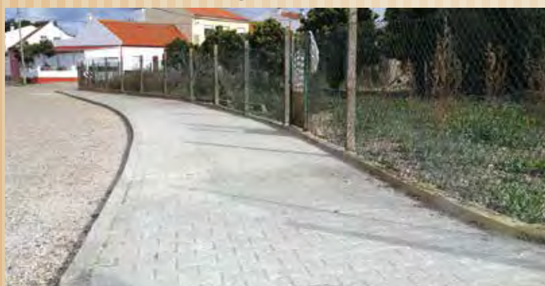
BAIRRO SÃO JOÃO — COLOCAÇÃO DE PASSEIO
