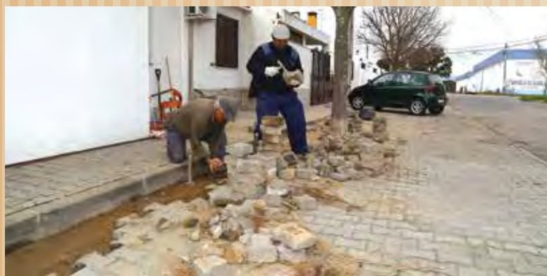
BAIRRO VALE PEREIRO — REMOÇÃO DE RAÍZES
