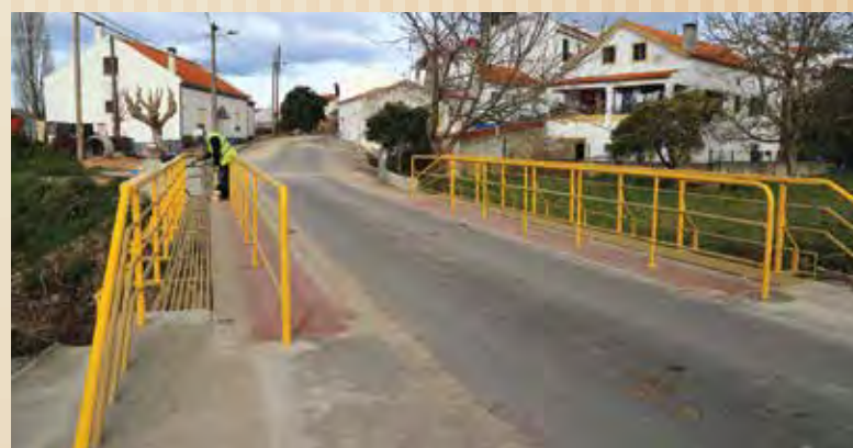
MELIDES — REABILITAÇÃO DA PONTE DE PAU
