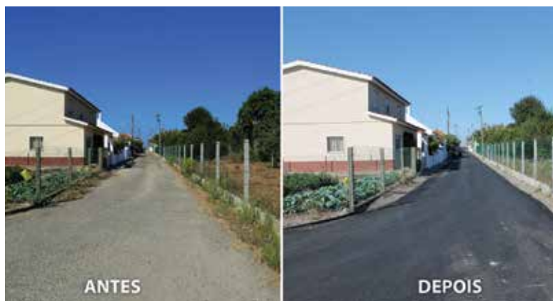
RUA GENERAL HUMBERTO DELGADO (TIRANA)
