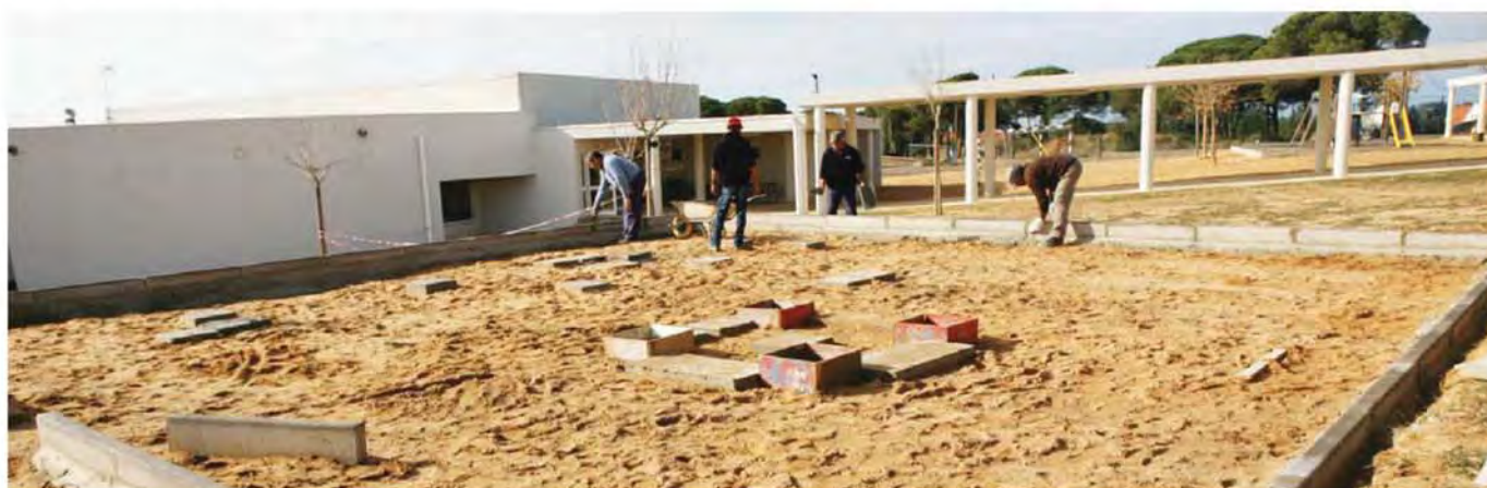
INSTALAÇÃO DE PARQUE INFANTIL NO CENTRO ESCOLAR DE MELIDES
