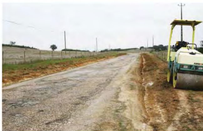
REPARAÇÃO DAS BERMAS DA ESTRADA DO VISO
