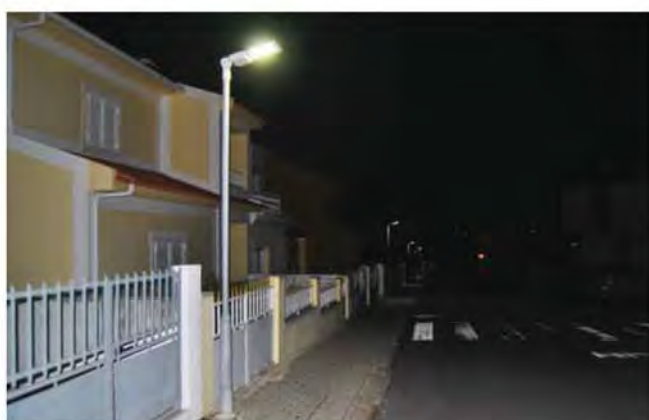
INSTALAÇÃO DE LUMINÁRIAS DE BAIXO CONSUMO
