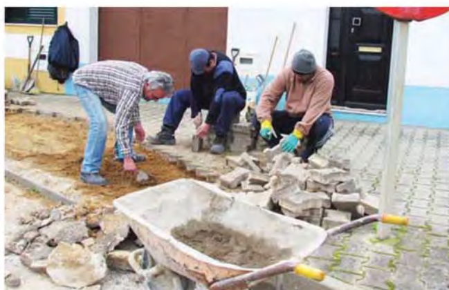
ARRANJOS DE PAVIMENTO — ZONA DOS RESTAURANTES — CANAL CAVEIRA
