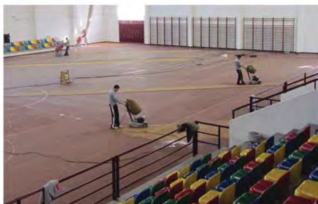
INTERVENÇÃO NO PISO DO COMPLEXO DESPORTIVO JOSÉ AFONSO
