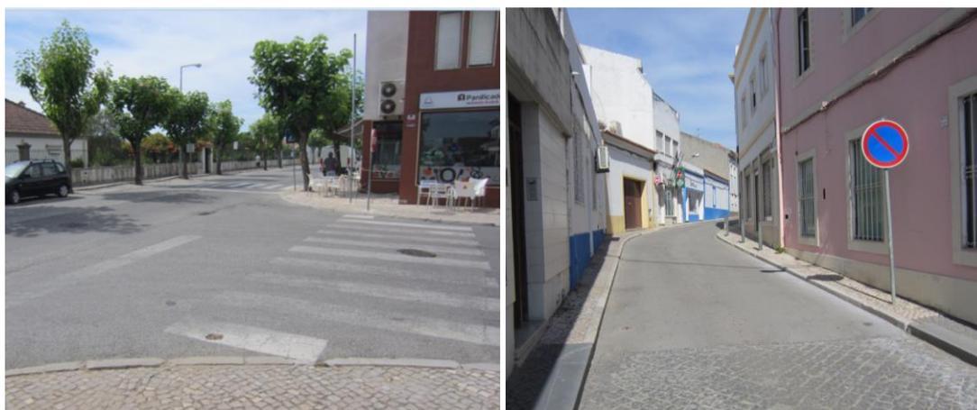
**Figura 20. Exemplos de incorreta execução de rebaixamentos dos passeios (esquerda) e passeios subdimensionados (direita)**
