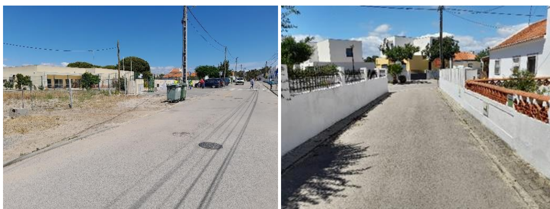
Figura 24. Exemplos de pavimento degradado e espaços pouco apelativos para a circulação pedonal
