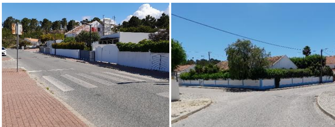
Figura 18. Exemplos de incorreta execução de rebaixamentos dos passeios (esquerda) e passeios subdimensionados (direita)
