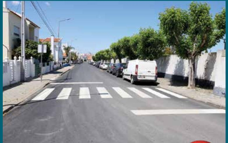
■ A empreitada para a requalificação de arruamentos e passeios compreendeu 4 zonas da vila, num total de 15 ruas. A intervenção, no valor de 267 282,86 €, incluiu a fresagem do pavimento existente, a aplicação de tapete betuminoso em toda a faixa, pintura de sinalização horizontal (estacionamentos e passeadeiras) e, em alguns locais, a execução de passeios.
